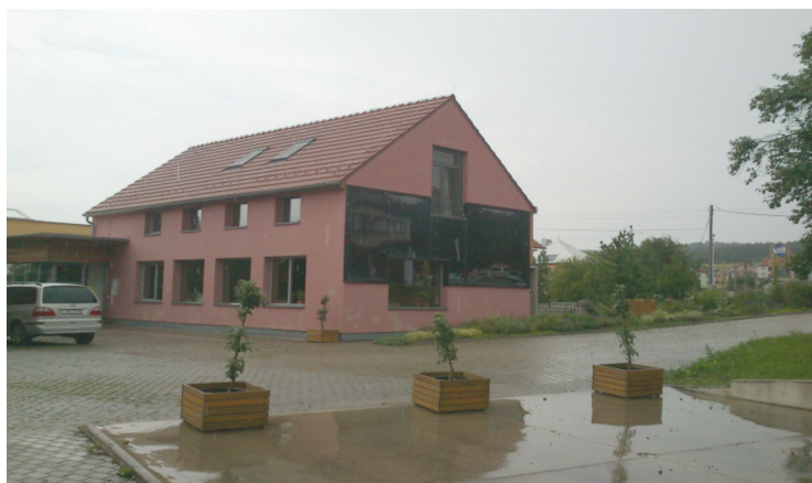
Nízkoenergetický dům v Hostětíně (sídlo české iniciativy) - první nízkoenergetický komunitní dům v Česku (používá se pro pořádání krátkodobých kurzů a dalších vzdělávacích aktivit, nabízí ubytování a pro ubytované i místní jídla - pokud možno z biopotravin, jsou v něm pořádány místních kulturních a společenských akce) Foto: Michal Lostak
